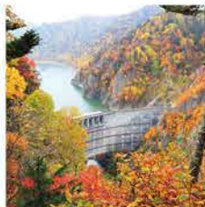
豊平峡ダム 豊平峡ダムライナー
