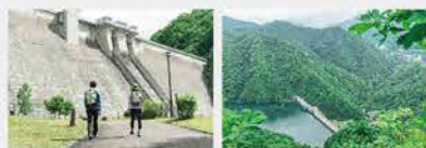
見上げていたダムを見下ろすことができる
